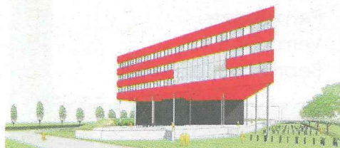
Het Wolfert Lyceum wordt verlengd op de 2e, 3e en 4e verdieping en de aanbouw staat op palen.
